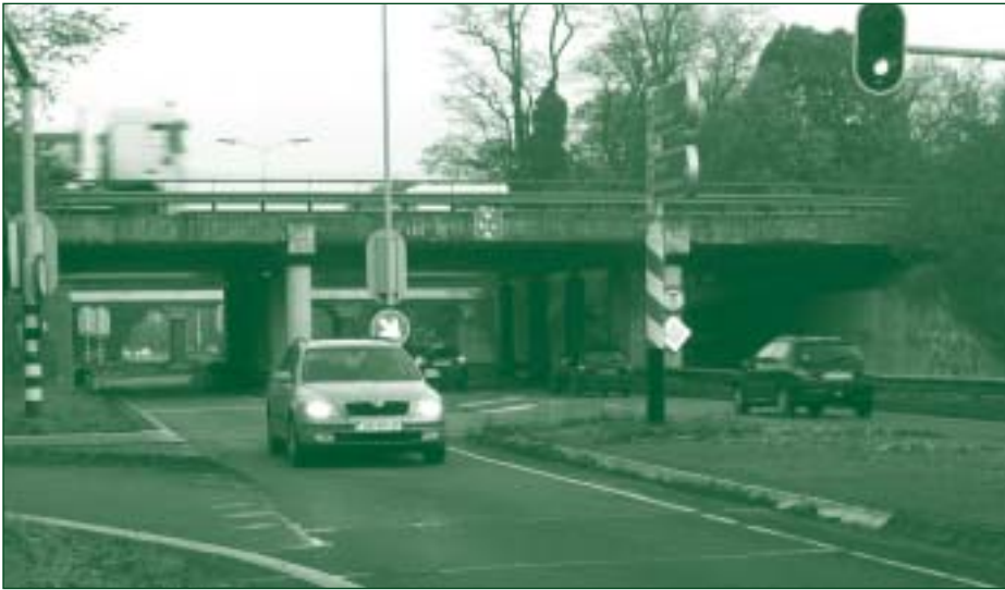
Amersfoortseweg met het te vervangen viaduct. Ook de op- en afrit richting Utrecht wordt vernieuwd. De A12 loopt straks vlak langs Meubin.
