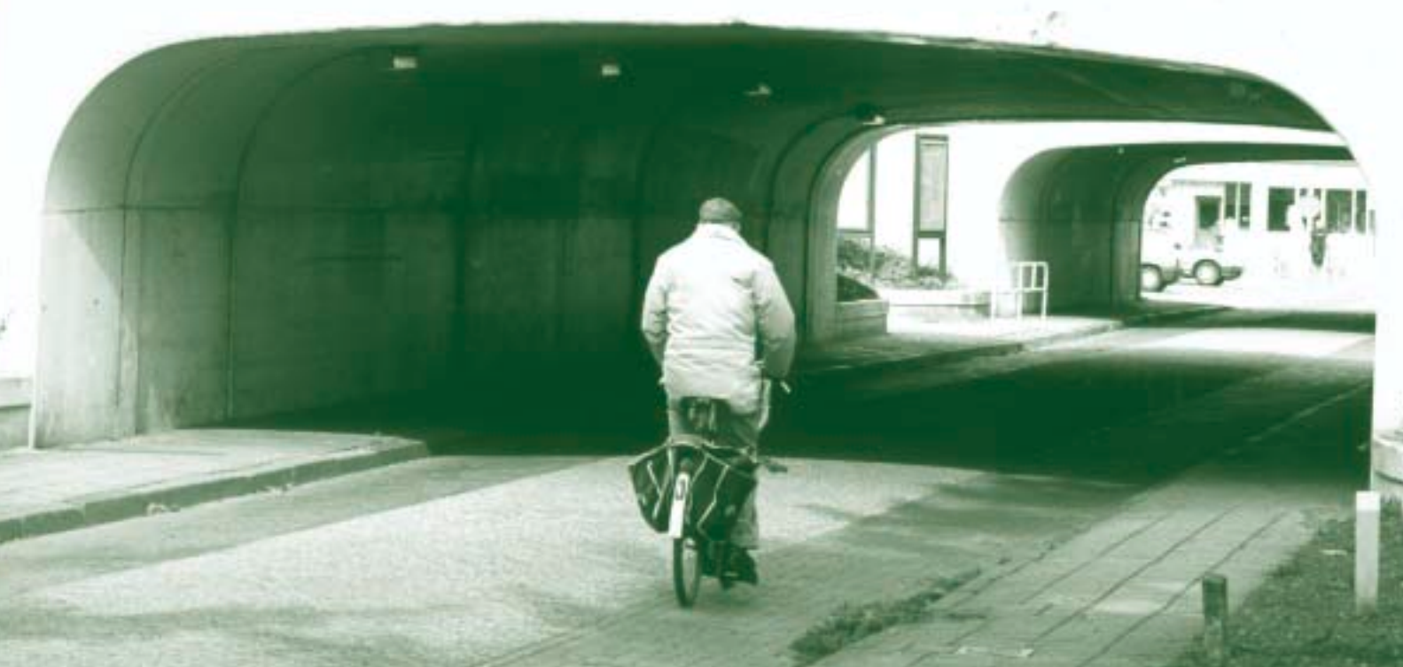
De Raadhuis tunnel in Maarn.
